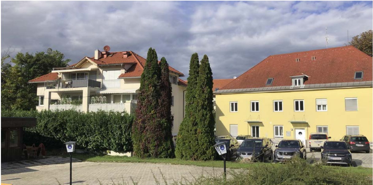
Foto 02: Gemeindeamt mit Parkplätzen (wird Veranstaltungssaal) und im Westen angrenzendes Wohnhaus
