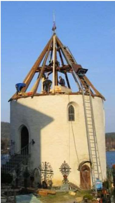
Der Dachstuhl und das Schindeldach des Karners werden von Osttiroler Spezialisten erneuert. Diese Arbeiten werden voraussichtlich bis Ostern dauern.
